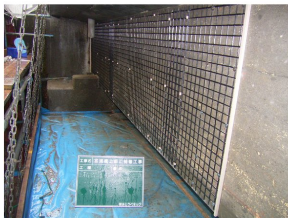
FRPグリッド取付完了
