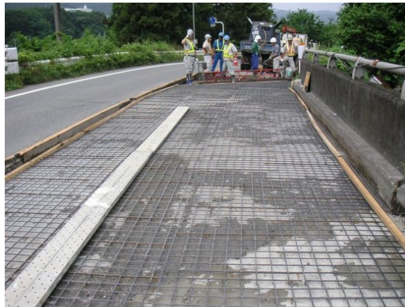
床版上面の補強
