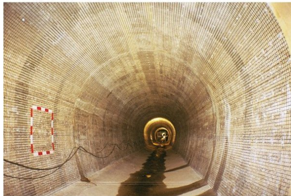
水路トンネル覆工の補強
