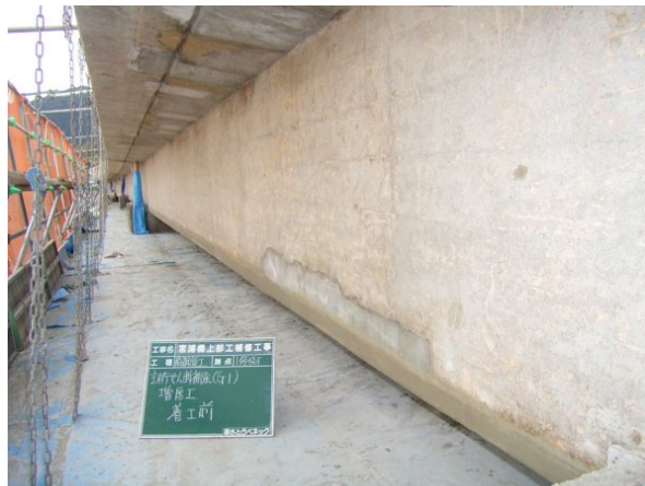
橋梁桁せん断補強着工前
