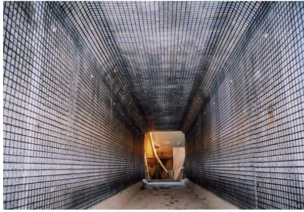
ボックスカルバートの補強
