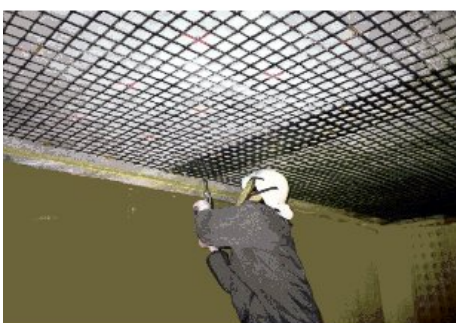
FRPグリッド取付状況
