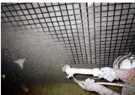
モルタル吹付状況
