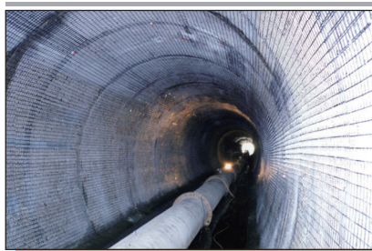
水路トンネル
