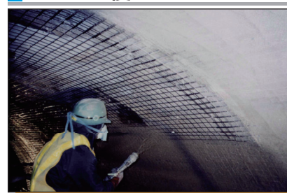
トンネル覆工
